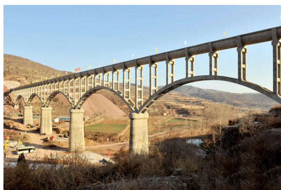
图 1 渡槽结构
